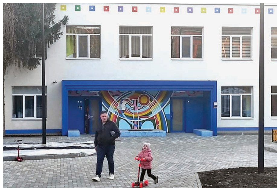
В ходе капремонта в детском саду № 63 обновили фасад и входную группу.
