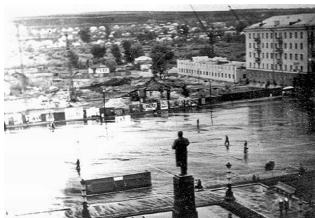
Площадь Революции перед строительством здания драматического театра.
