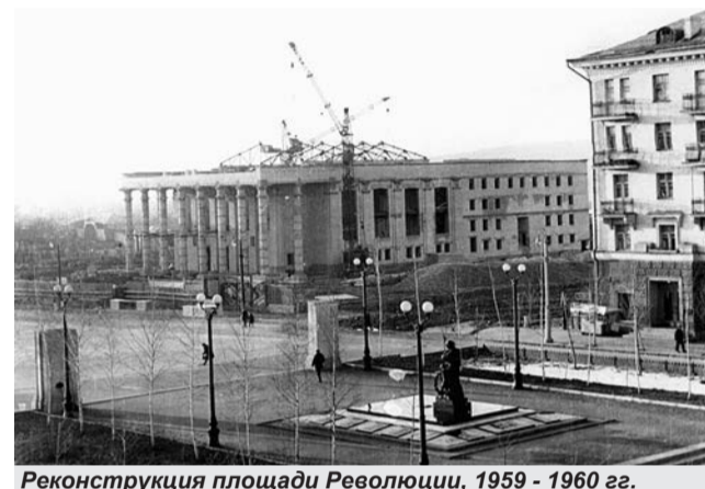
Реконструкция площади Революции, 1959 - 1960 гг.
