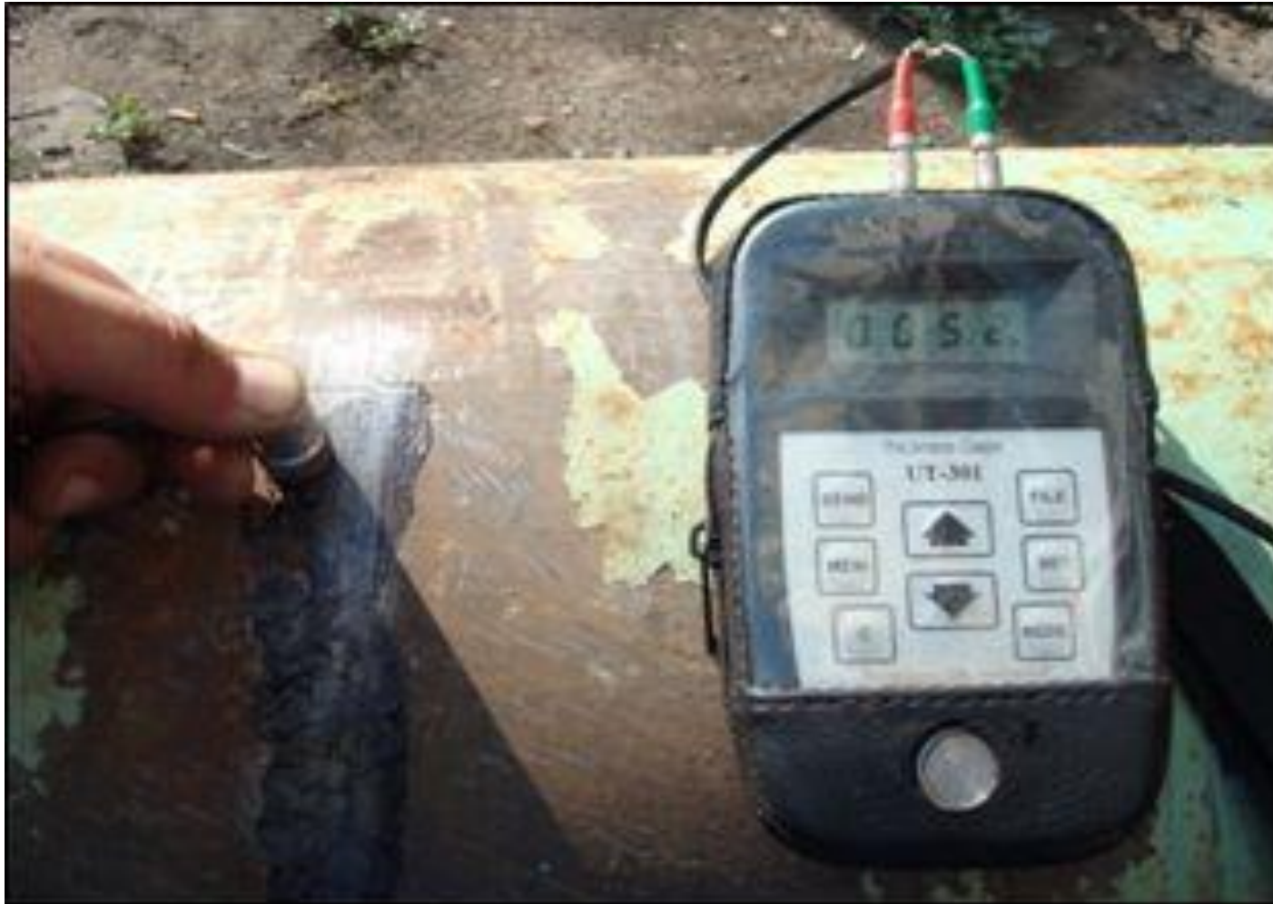
Фото 2. Замер фактической толщины стенок трубопровода с помощью ультразвукового толщиномера UT-301.
