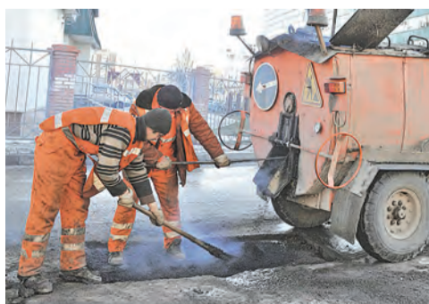
Дороги ремонтируют круглосуточно
