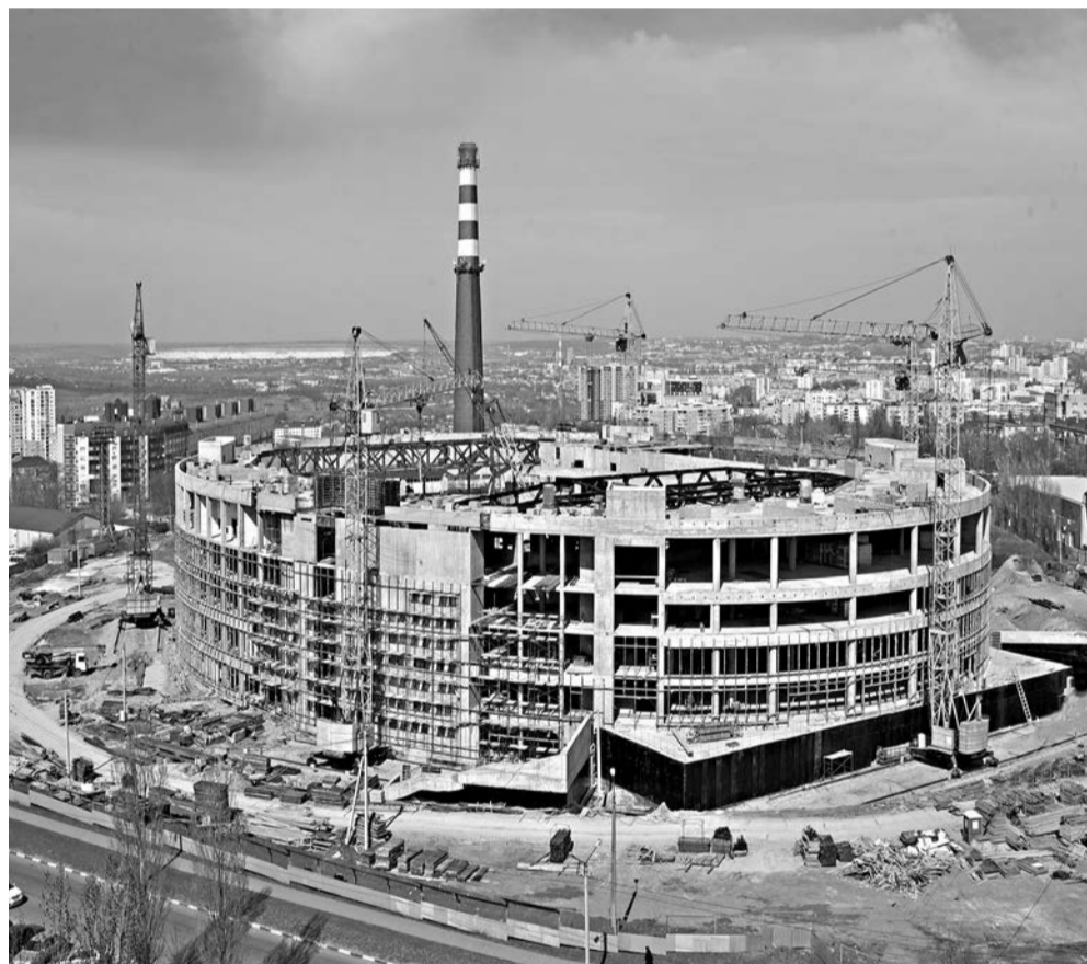
Так выглядит строительство сейчас.
