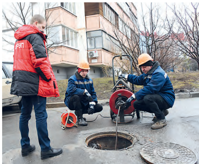
Сотрудники «ДРЭП ДСК» приводят в порядок систему водоотведения.
