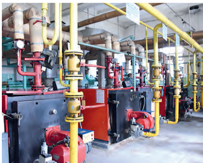
Котельный цех по ул. Щорса.
