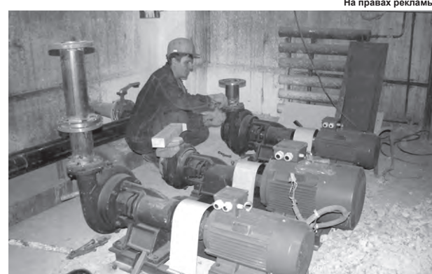
Монтаж насосов для приготовления известкового молока.
