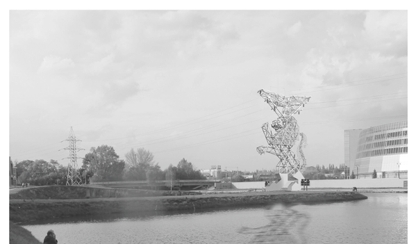
Общий вид опоры №2 НТПО110-2
