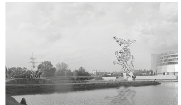
Общий вид опоры №2 НТПО110-2
