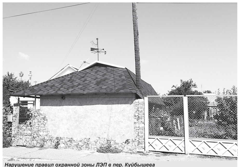
Нарушение правил охранной зоны ЛЭП в пер. Куйбышева
