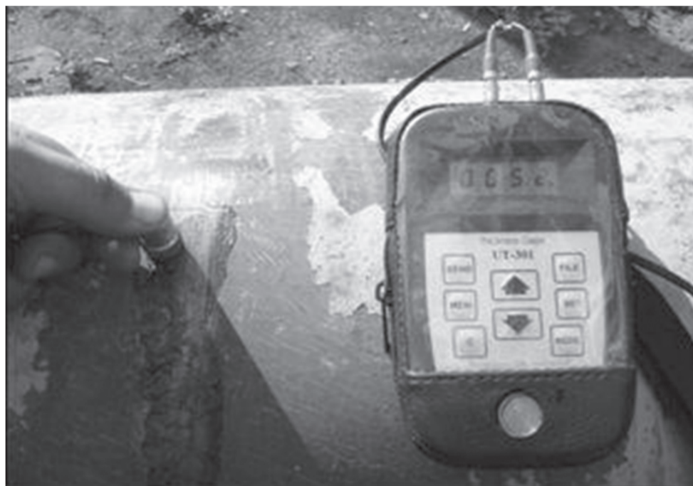
Замер фактической толщины стенок трубопровода с помощью ультразвукового толщиномера УТ-301. Фото. 9.2
