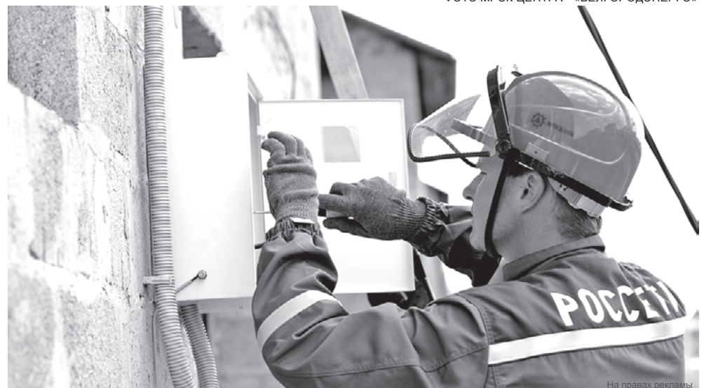
ФОТО МРСК ЦЕНТРА - «БЕЛГОРОДЭНЕРГО»
