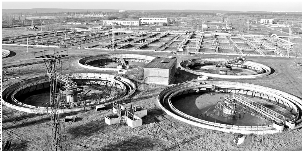
Городские очистные сооружения.
