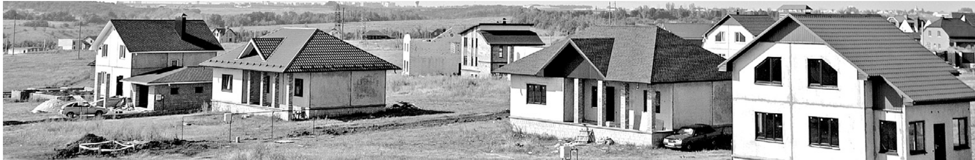
Строительство индивидуальных домов для пайщиков в п. Северном.
