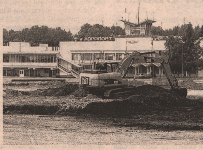
Реконструкция идёт полным ходом.
