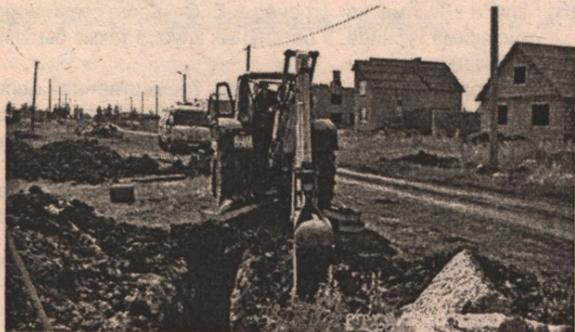
...При проведении земляных работ для прокладки канализационных систем экскаватор прорвал подземный полиэтиленовый газопровод диаметром 110 мм.
