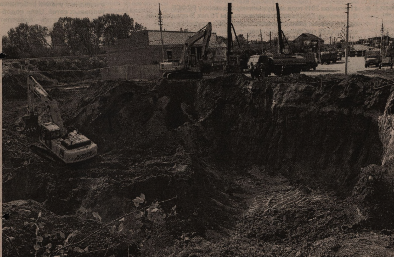
Котлован под будущий тоннель роют экскаваторщики ООО «Белдорстрой»
