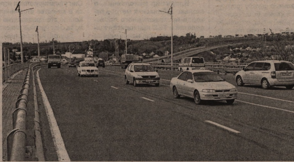
Мост в районе «Спутника»
