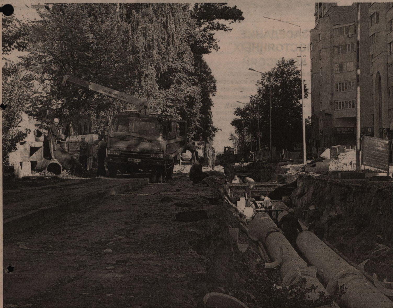
Ремонт тепловых сетей по ул. Октябрьской
