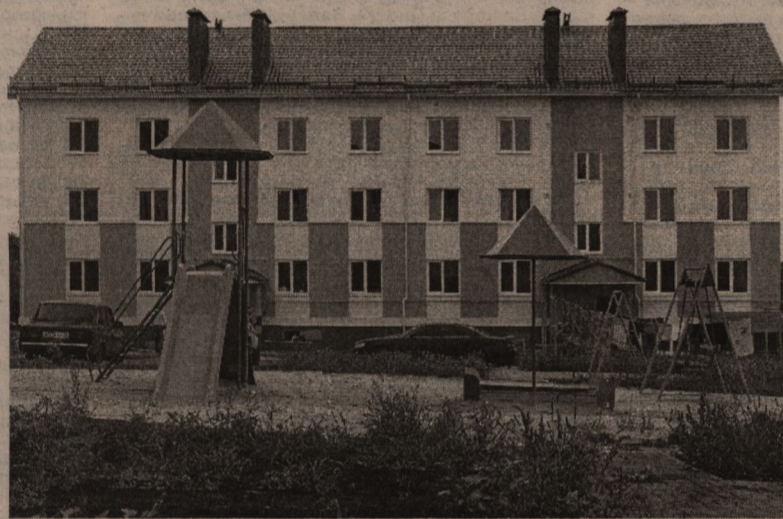
Кроме индивидуального здесь ведется и малоэтажное строительство
