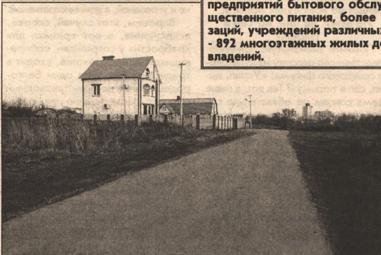
Этой дороги с твердым покрытием на ул. Набережной недавно еще не было
