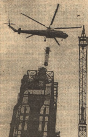
На снимке: в сложных метеоусловиях работают авиаторы и строители.
