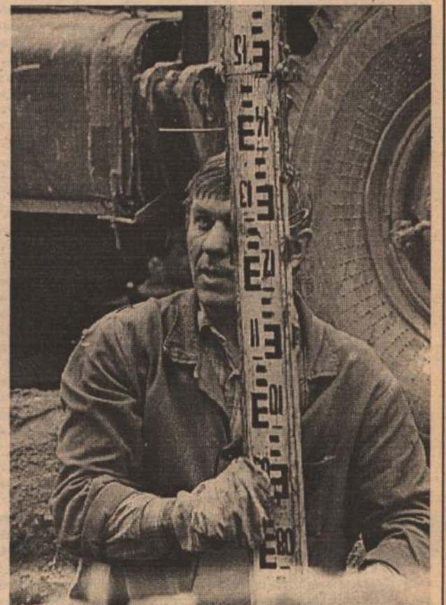
Сергей Молчанов из ПМК-5 со своей бригадой завершил прокладку ливневой канализации на углу улиц Воровского и Победы.
