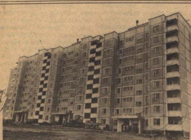
В доме нет света, воды, газа. Трагедия? Ничего подобного — новоселы радуются, поздравляют друг друга. И еще успокаивают меня, газетчика: «Все проведем, подключим. Сами построили сами порядок наведем». Удачи тебе, МЖК! Фото Бориса ЕЧИНА.
